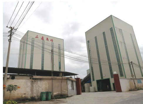
项目南面（正通商砼）
