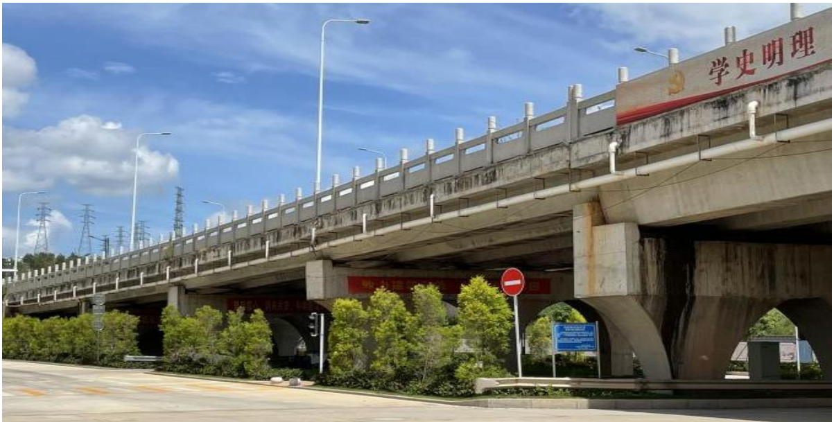
雨水收集管网
