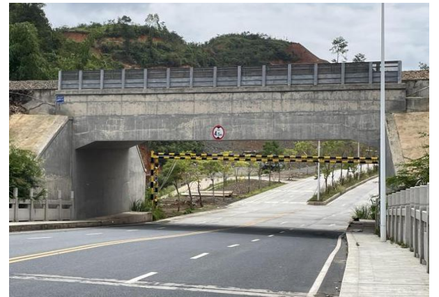
连接下穿铁路部分
